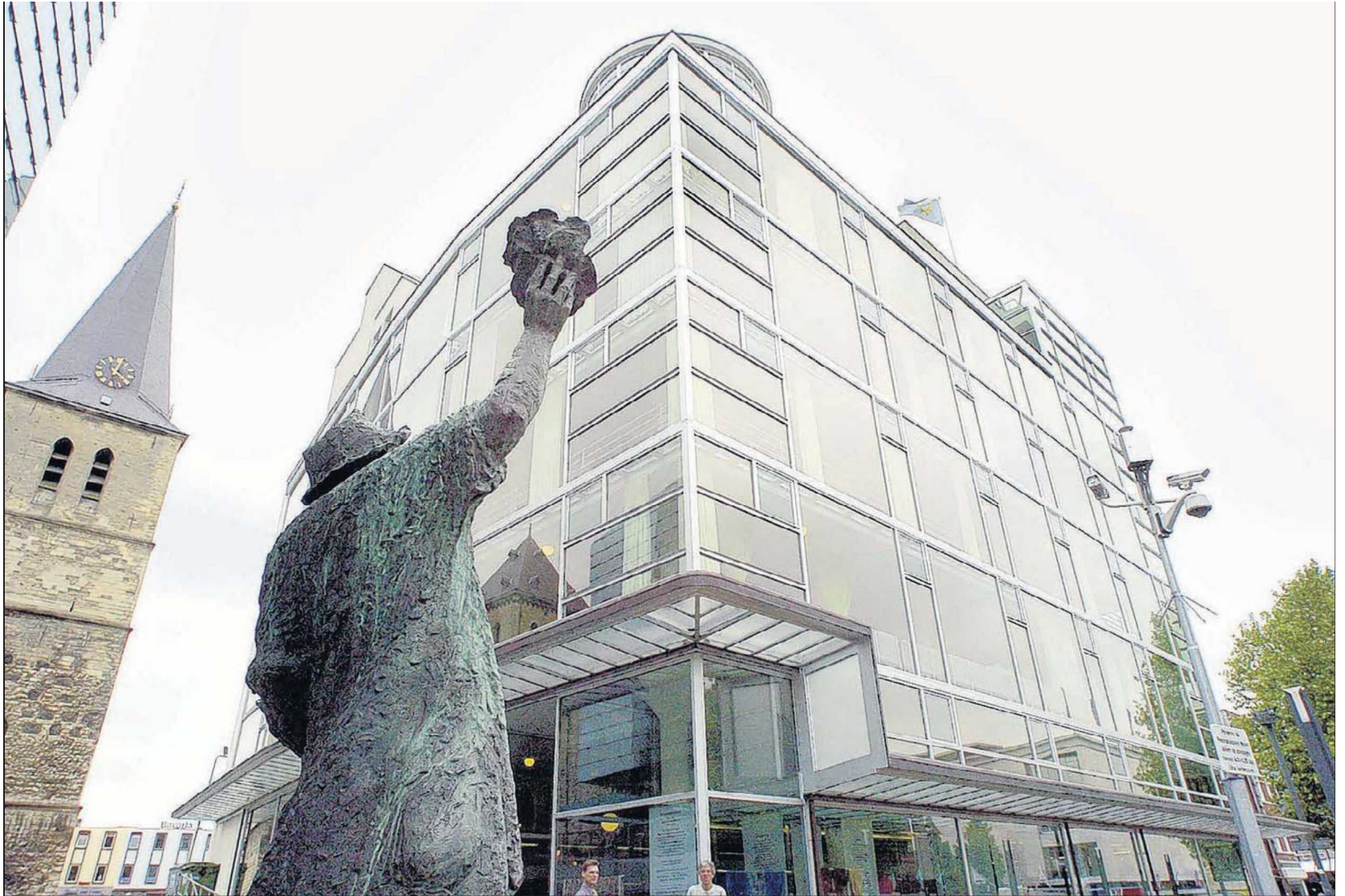
Het gerenoveerde Glaspaleis kampt met een lekkage in de kelder.
